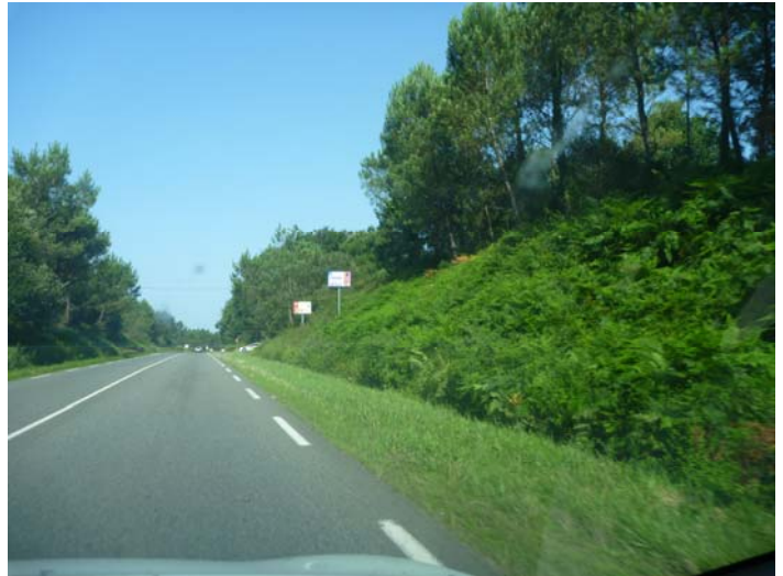
Ondres, en bord de D85: le projet de zone AUhf en extension des allées Shopping semble abandonné. Exercer une veille sur ce point dans le projet de zonage du PLUi
