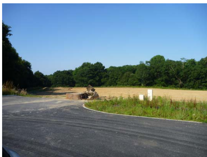
Parc d'activité du Seignanx à St Martin, 1e zone la plus orientale en cours de viabilisation. On note une forte proximité avec des espaces paysagers de qualité et des sols pentus qui vont nécessiter de forts terrassements...
