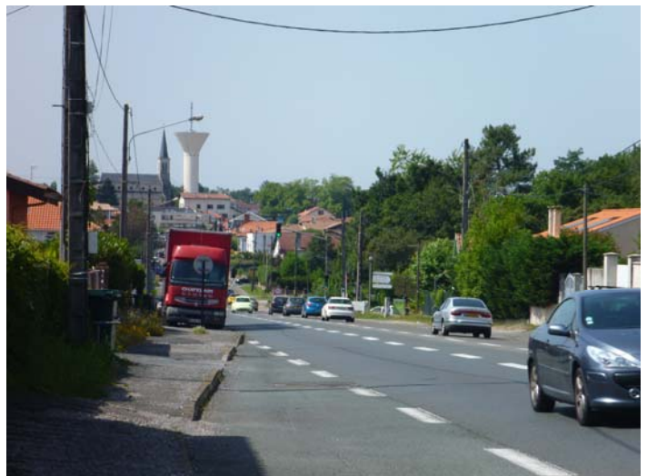
Ondres: un enjeu paysager fort: la traversée de la ville et l'aménagement de ses espaces publics
